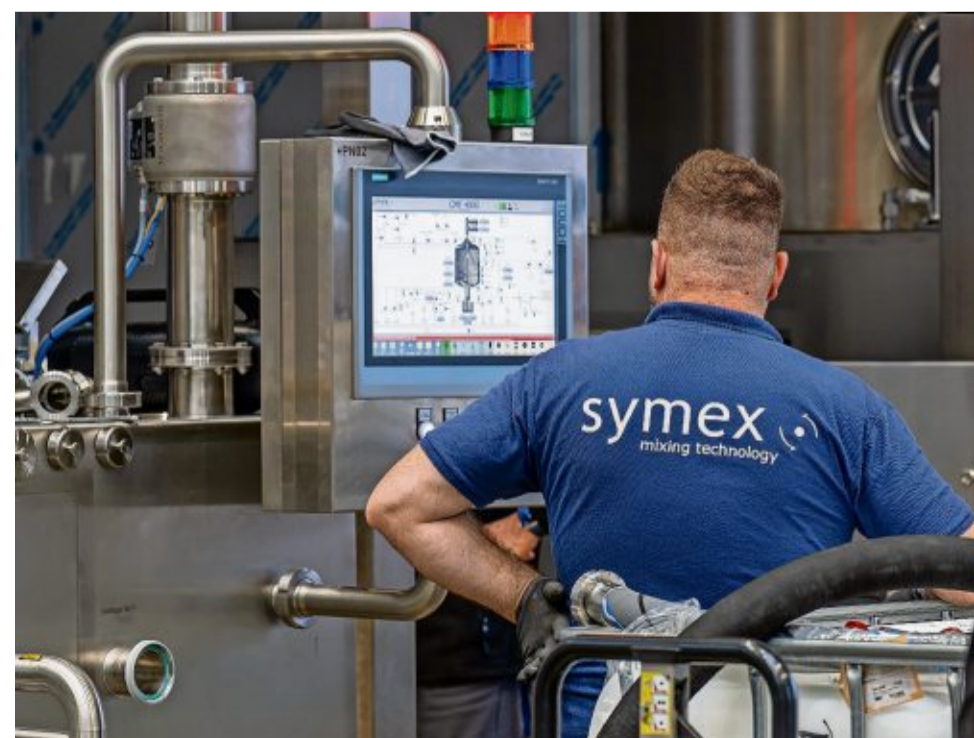
Ein Mitarbeiter der Firma Symex schaut auf den Bedienbildschirm einer Anlagensteuerung.
