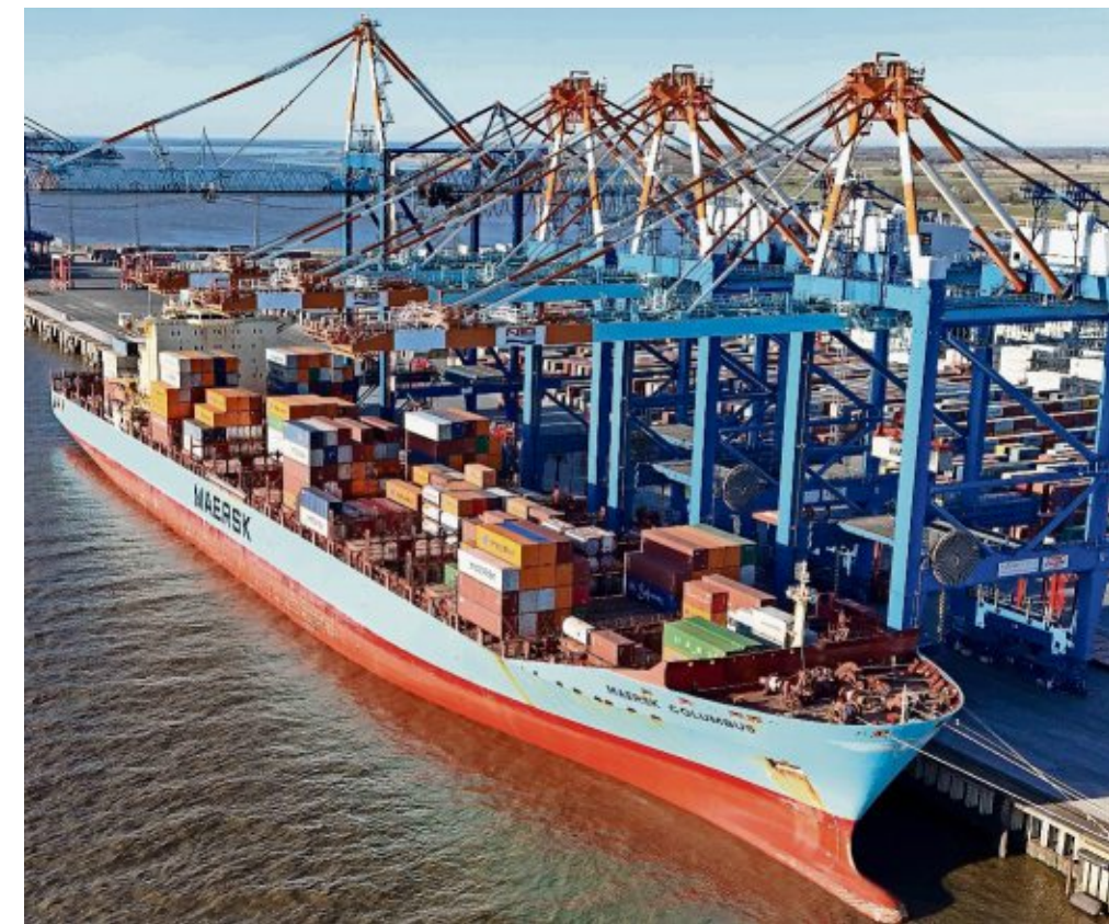
Für die Stromkaje in Bremerhaven sind massive Investitionen notwendig.
