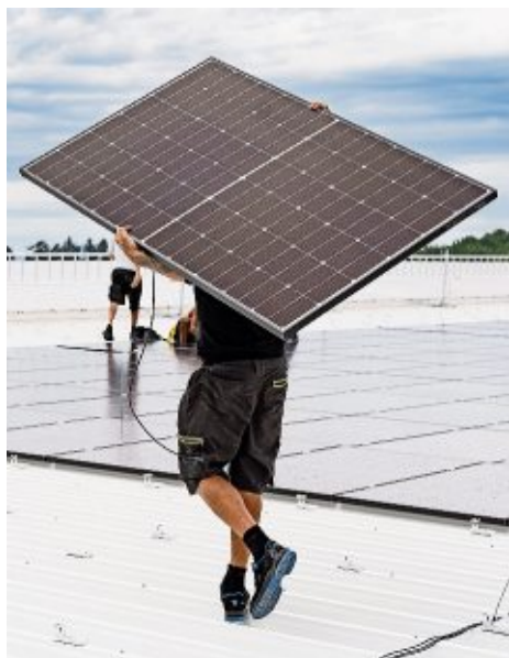
Ein Monteur trägt ein Modul einer Photovoltaikanlage zur Installation auf einer Dachfläche. Foto: pr
