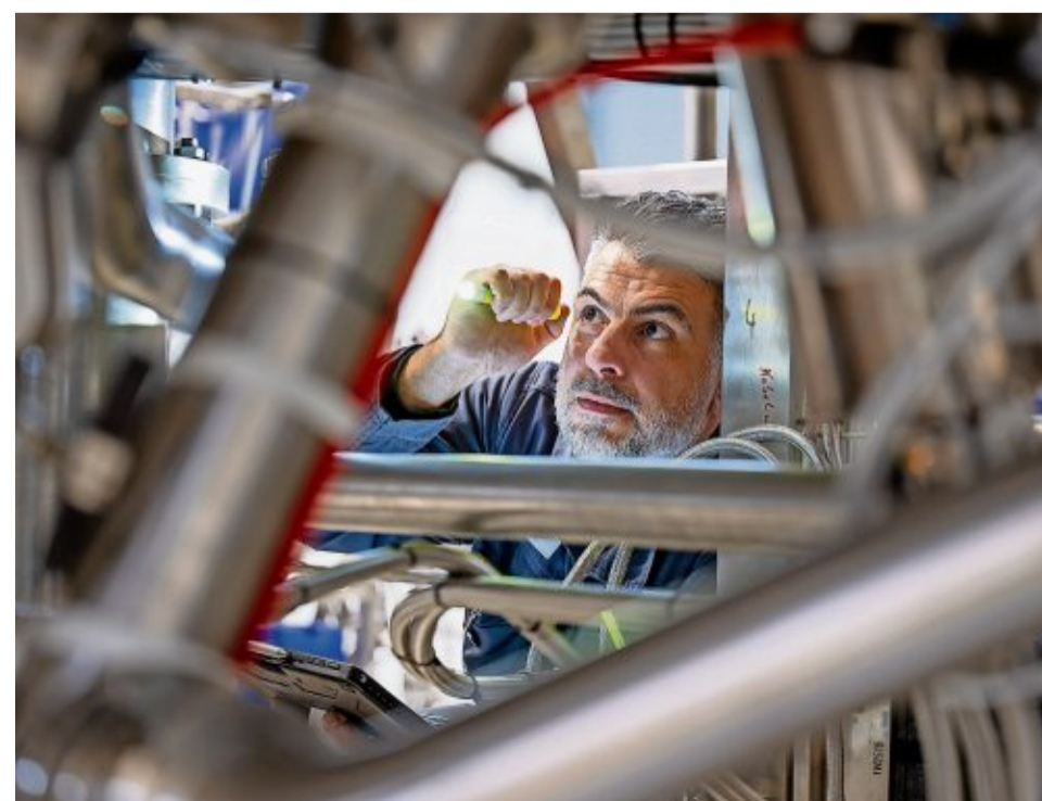
Mitarbeiter und Inbetriebnehmer Göcksel Aran bei der Arbeit in der Produktionshalle in Bremerhaven.
